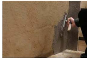
2. Auftragen eines Lehm- oder Kalkputzes zum Ausgleich der Unebenheiten in der Oberfläche des Feldsteinmauerwerks.
