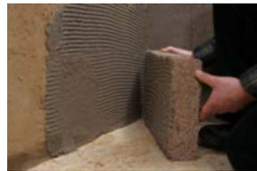
4. Die trockenen CELLCO® Wärmedämmlehm-Platten in die feuchte Kontaktschicht hohlraumfrei ansetzen und eindrücken.
