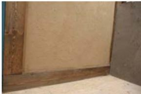
1. Entfernen von losen Putzteilen und Nacharbeiten der alten Feldsteinmauerwerksfugen, um einen homogenen Aufbau zu ermöglichen.
