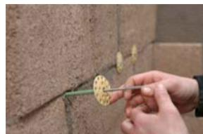
6. Zur langfristigen Kontaktsicherung die Eckpunkte der Plattenstöße mit Tellerdübeln versehen. Danach kann die Oberfläche verputzt werden.
