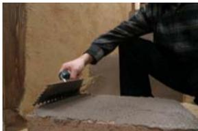
3. Nach dem Austrocknen der Ausgleichsschicht CELLCO® CDM auftragen. In 1 - 3 mm Stärke mit einer Glättkelle verarbeiten.
