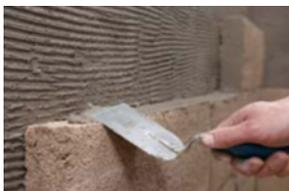
5. Sämtliche Plattenstöße mit CELLCO® Contact-Dämm-Mörtel einstreichen und somit den Verbund zwischen den einzelnen Platten herstellen.
